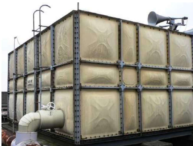
施工前 (FRP製 高置水槽)
