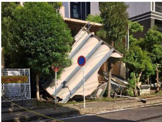
経年劣化から破裂事故
