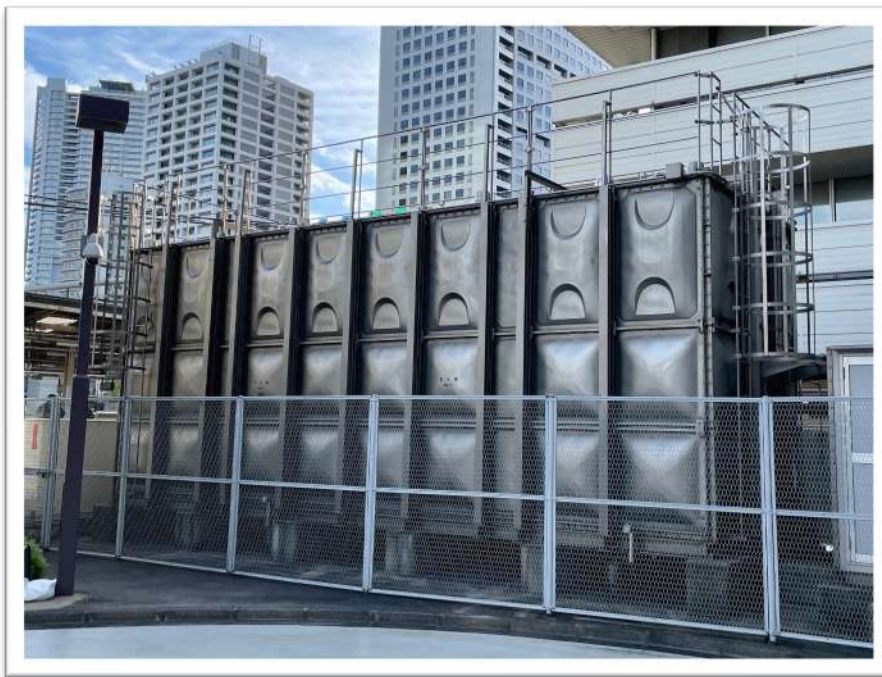
JR田町駅に隣接する新田町ビル、95tの受水槽（設置38年目）
