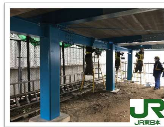
東日本旅客鉄道株式会社 様 2018年度より 駅ホーム下鉄骨に採用
